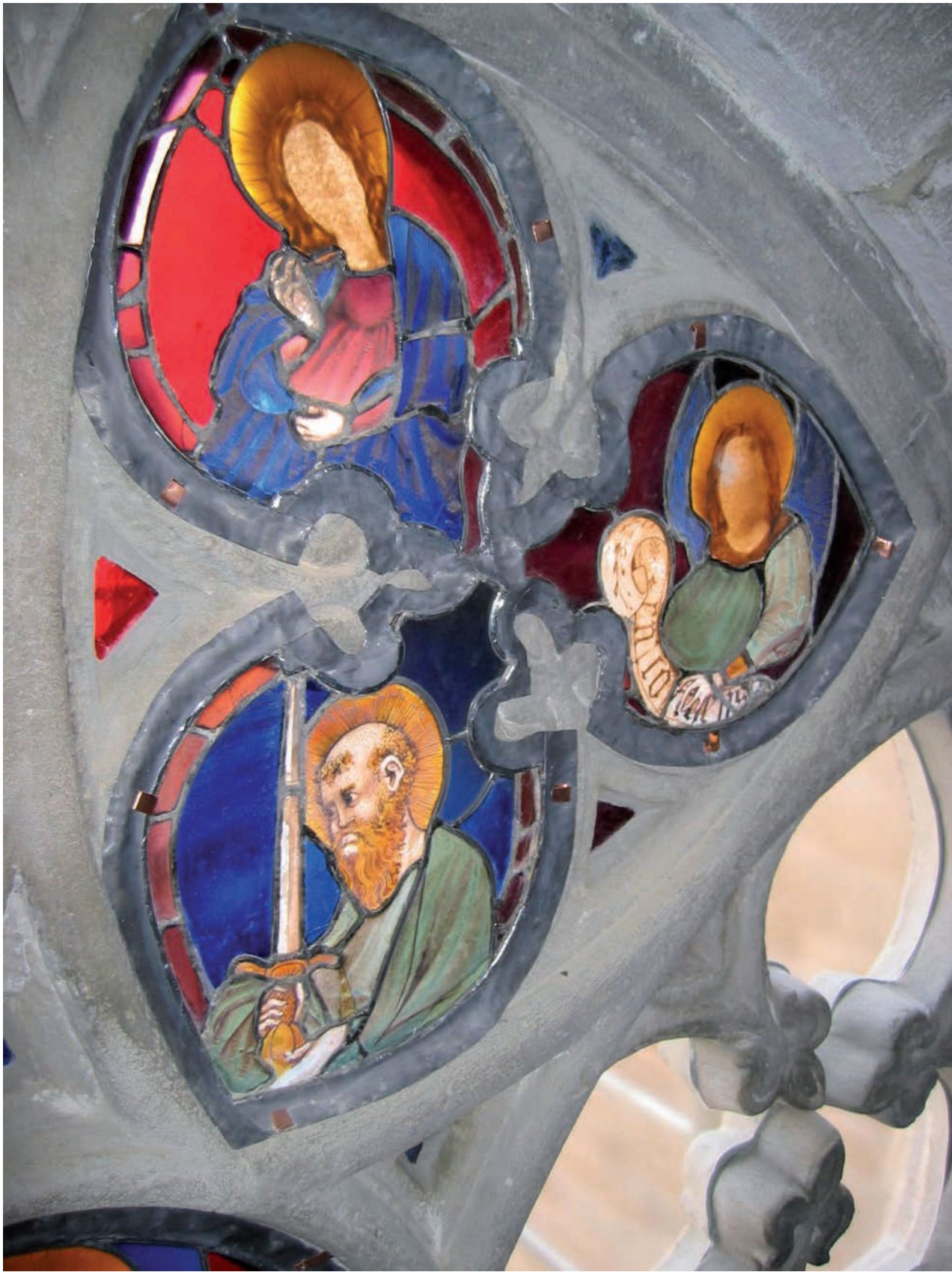
Nova instal·lació dels plafons
