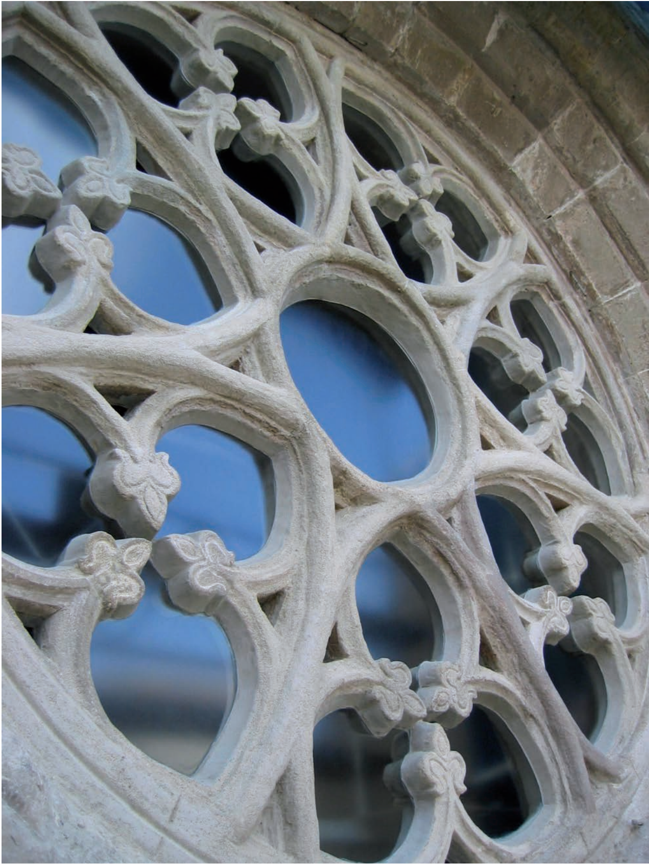
La rosassa tota refeta i amb els vidres de protecció
